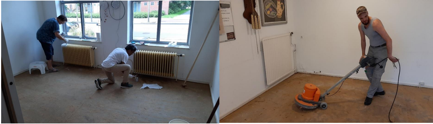
De vrijwilligers van de Brug, schilderen en egaliseren voordat de nieuwe vloer gelegd kan worden
